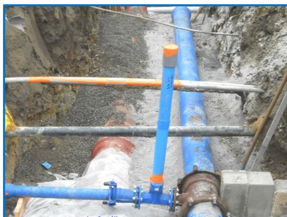
Figure 8. Travaux de renouvellement de réseaux
