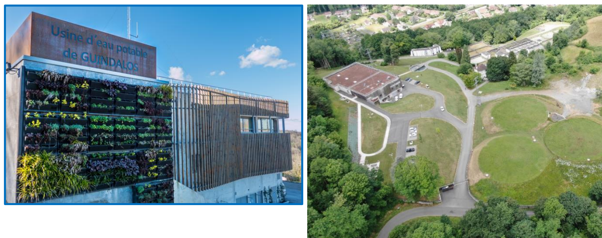
Figure 5. Site de Guindalos : nouvelle usine et réservoirs
