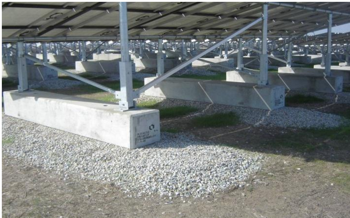
Figure 13 : Structure porteuse avec longrine en béton
