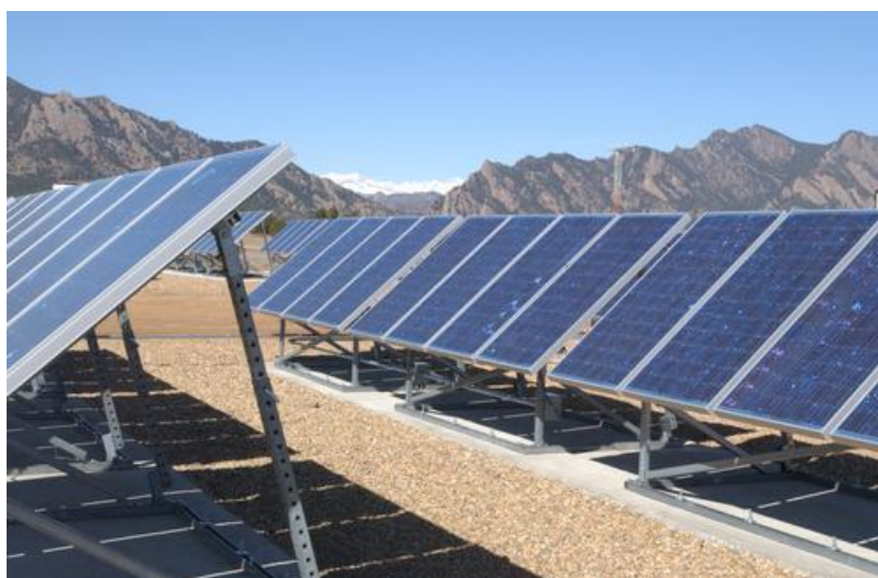
Figure 14 : Structure porteuse avec dalle en béton
