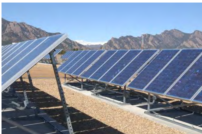
Figure 14 : Structure porteuse avec dalle en béton
