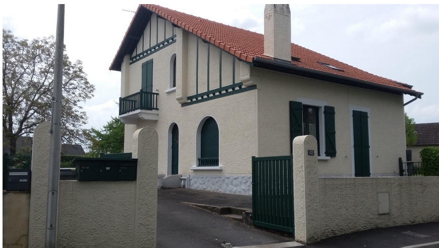
Mur de clôture correspondant à l'architecture de l'édifice, par le dessin, le matériau (enduit) et la teinte. Les piliers marquent l'accès alors que le mur est plus bas.
