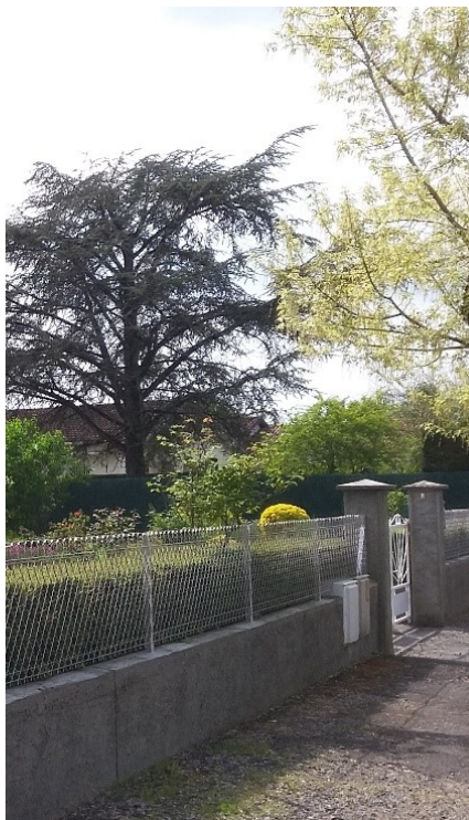
Articulation entre mur de clôture, grillage et haie, assurant une qualité de l'architecture.
