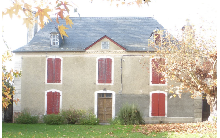
Maison en retrait offrant sa façade principale sur cour, ordonnancée autour de l'entrée, valorisée par un fronton.
