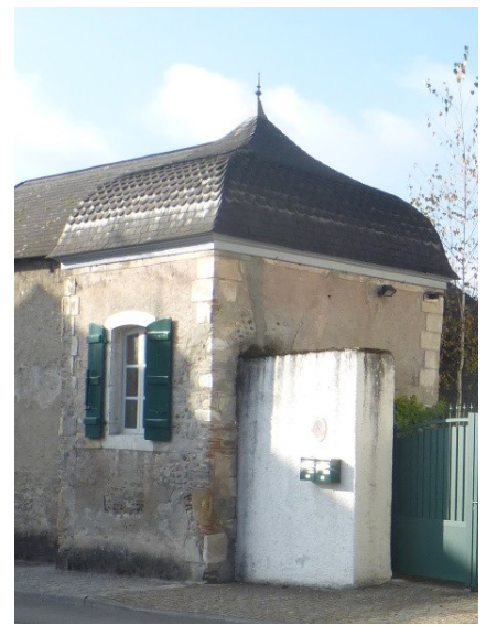
Génoise composée de tuiles inversées et de bandeaux en briques
