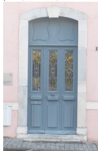
Porte vitrée à grands carreaux, Partie basse à panneaux, et imposte pleine, moulurée, fin XIX e
